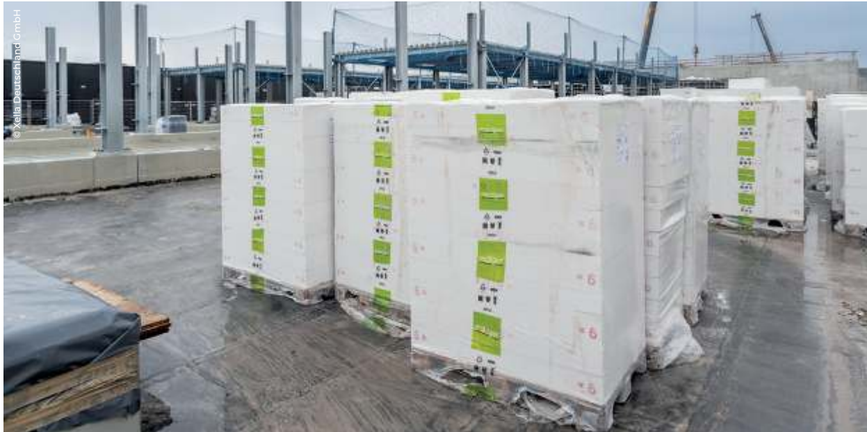
Bereit zum Einbetten in Heissbitumen: Multipor Flachdachdämmung DAA «gelandet».
