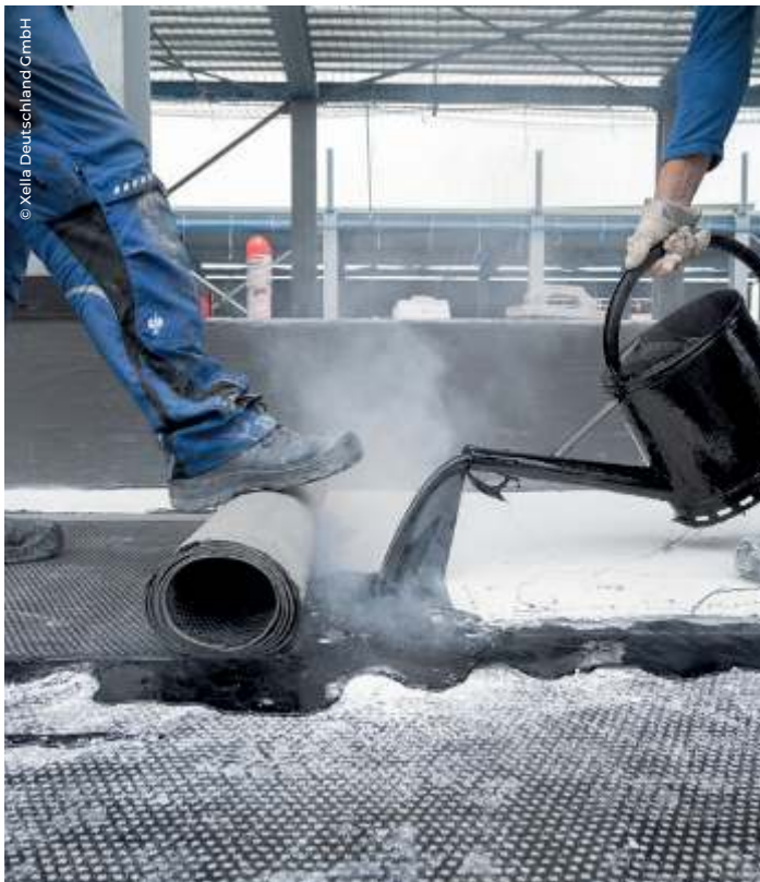
... und ebenfalls mit Heissbitumen mit der Dämmschicht verbunden.
