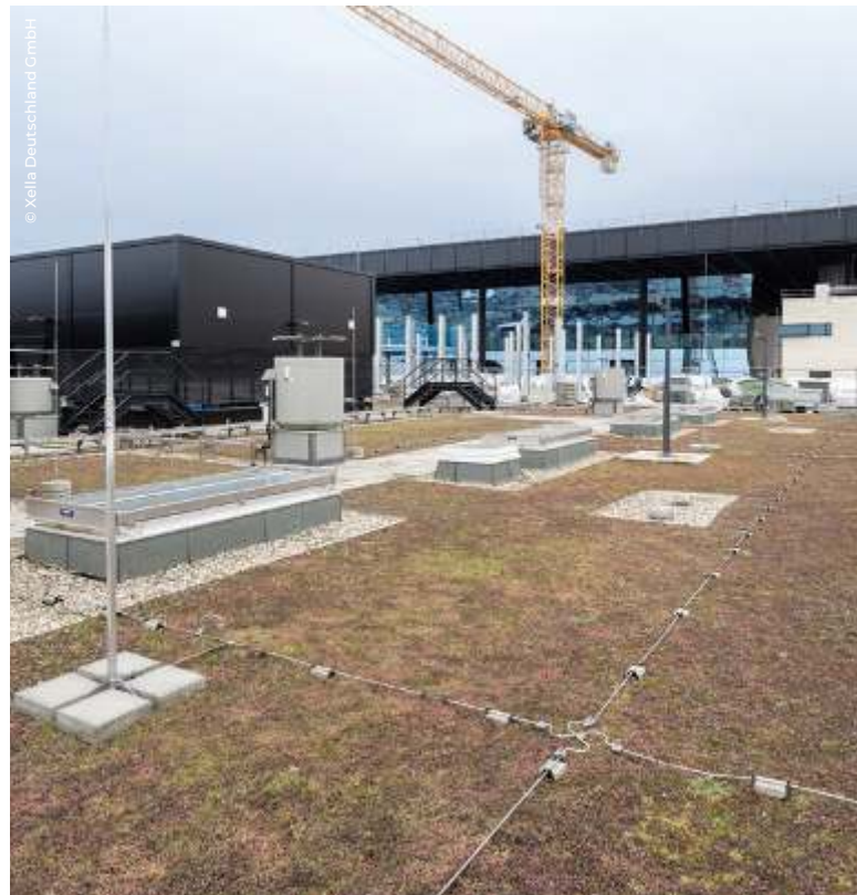
Geeignet für alle Arten von Auflasten: Betonplatten in den begehbaren Bereichen, Bekiesung, extensive Begrünung und Klimatechnik.
