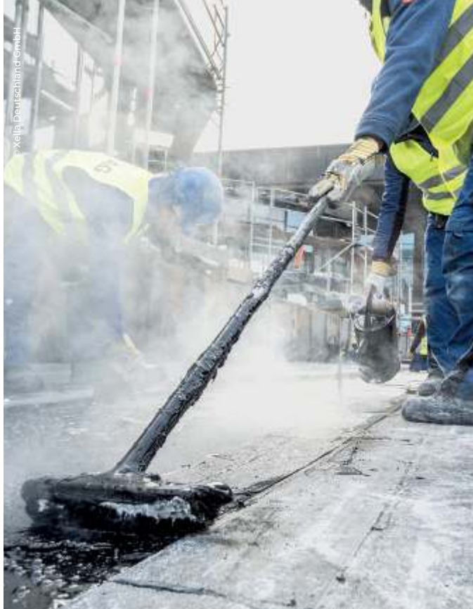
Als erste Abdichtungslage im mehrlagigen Aufbau wird eine Elastomerbitumenbahn verlegt ...
