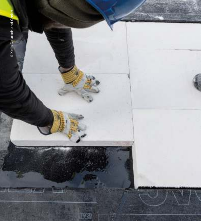
Aufbau und Arbeitsschritte: Dampfsperre, Heissbitumen, Multipor...
