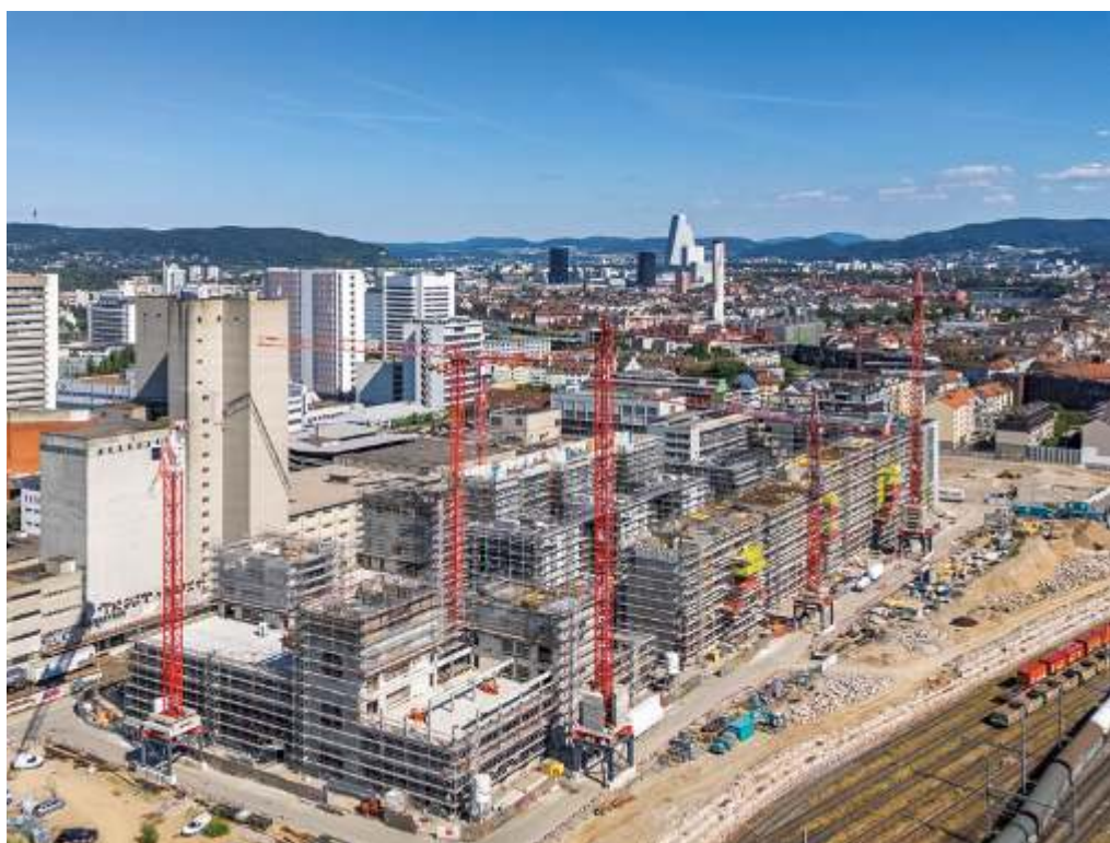
Baufortschritt beim Projekt Volta Nord in Basel, das Losinger Marazzi als Totalunternehmerin für die SBB realisiert.
