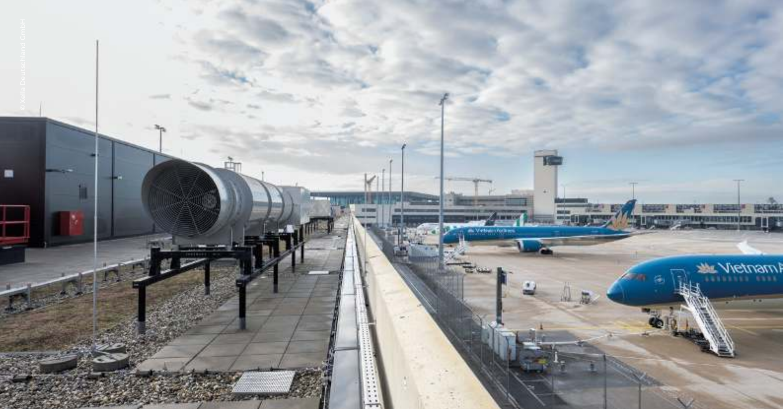
Flugsteig G: Auf dem Dach ist dank Multipor energetisch alles im grünen Bereich.
